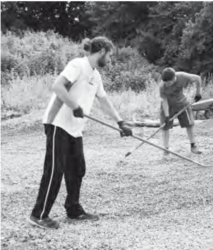
Auf der Fläche der ehemaligen Flugzeugreparaturhalle wurde Kies aufgebracht.
