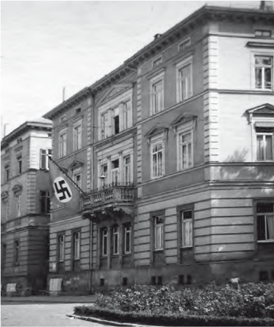
Nach dem Zwangsverkauf des Wohn- und Kanzleigebäudes der Familie Hayum an die Stadt Tübingen zog dort die SA-Standarte ein. Foto: Geschichtswerkstatt Tübingen.
